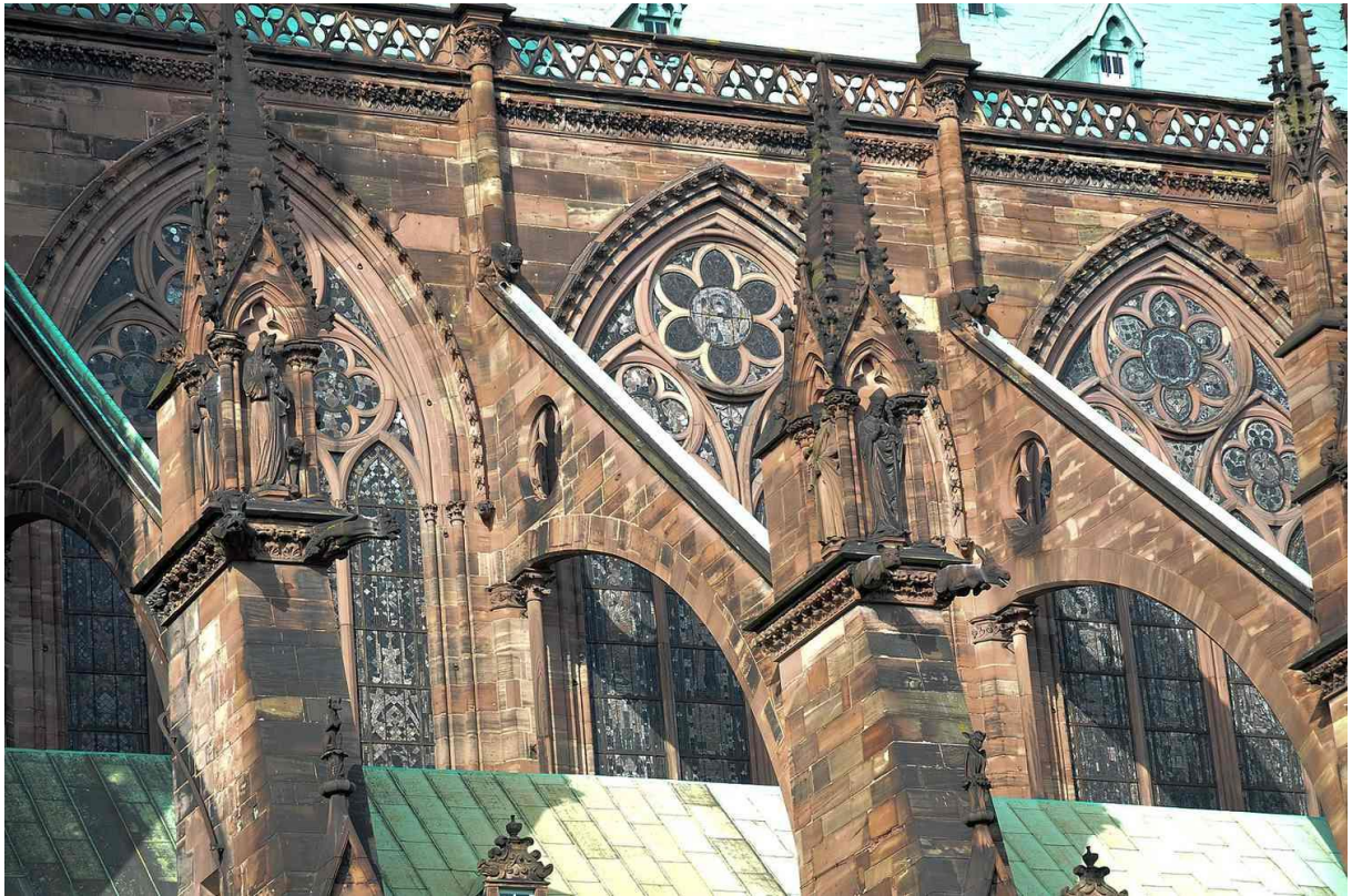
Contrafforti esterni (specialmente archi rampanti ) , elementi tipici dell'architettura gotica che rafforzano le pareti e permettono grandi vetrate.
